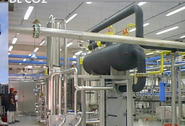
REMOÇÃO TOTAL DE NH 3 SUBSTITUÍDA POR SALMOURA
